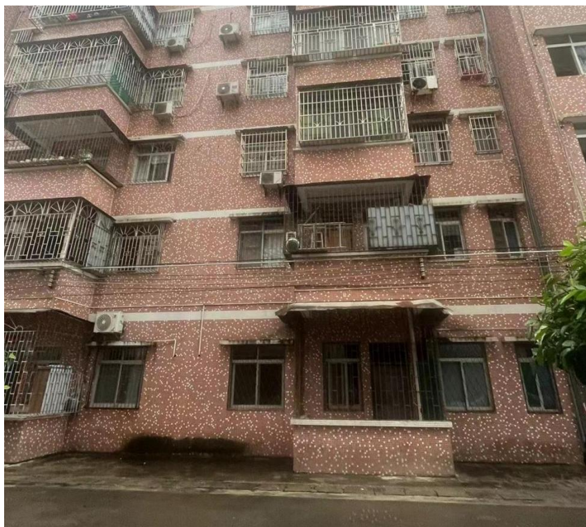
龙门县龙城街道塔新路安居苑第 6 幢 103 房
