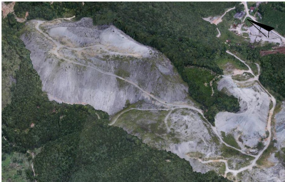
图 2-2 废弃土石堆现状
