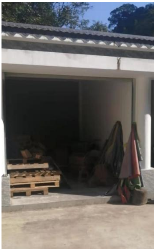
南昆山下坪社区川龙瀑布商铺 3 号
