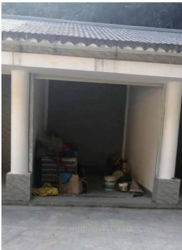
南昆山下坪社区川龙瀑布商铺 15 号
