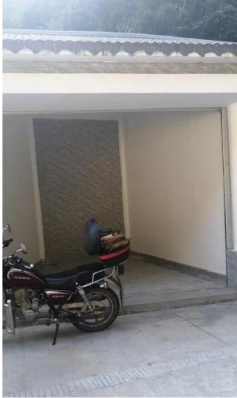
南昆山下坪社区川龙瀑布商铺 14 号
