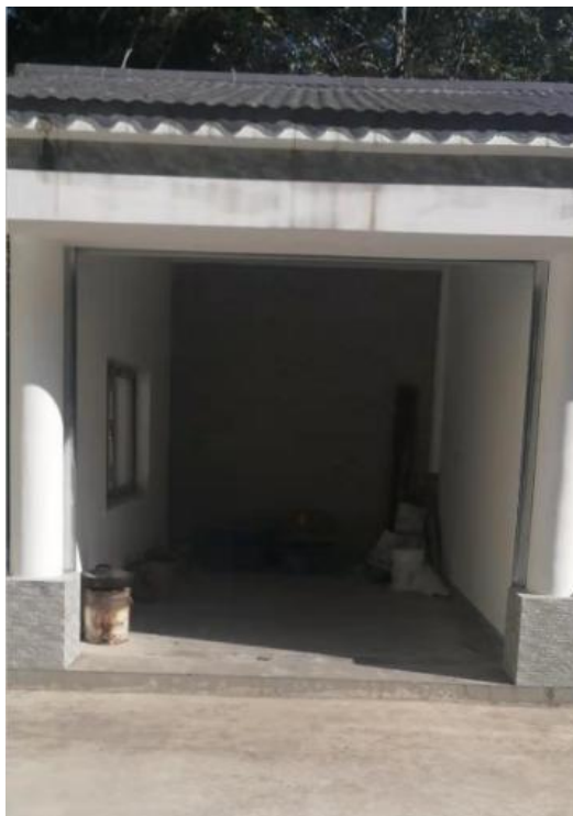
南昆山下坪社区川龙瀑布商铺 4 号
