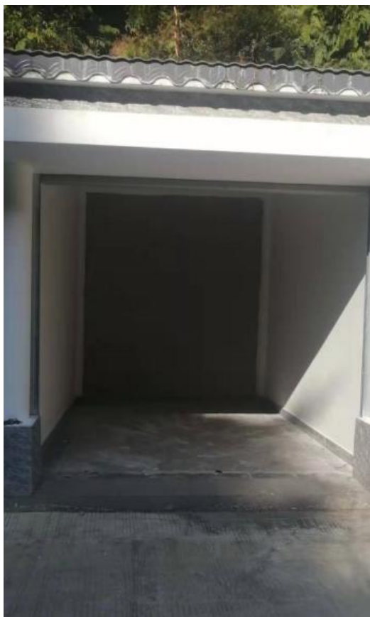
南昆山下坪社区川龙瀑布商铺 8 号
