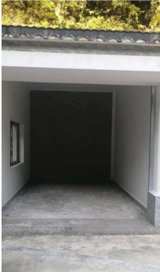
南昆山下坪社区川龙瀑布商铺 10 号
