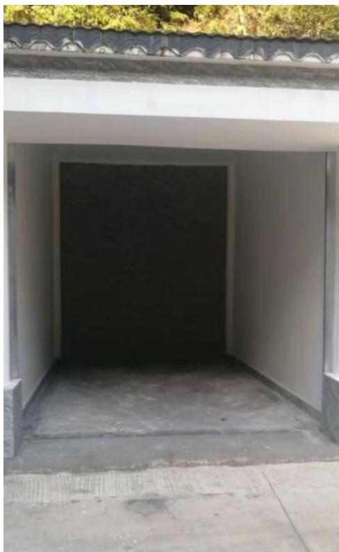
南昆山下坪社区川龙瀑布商铺 9 号
