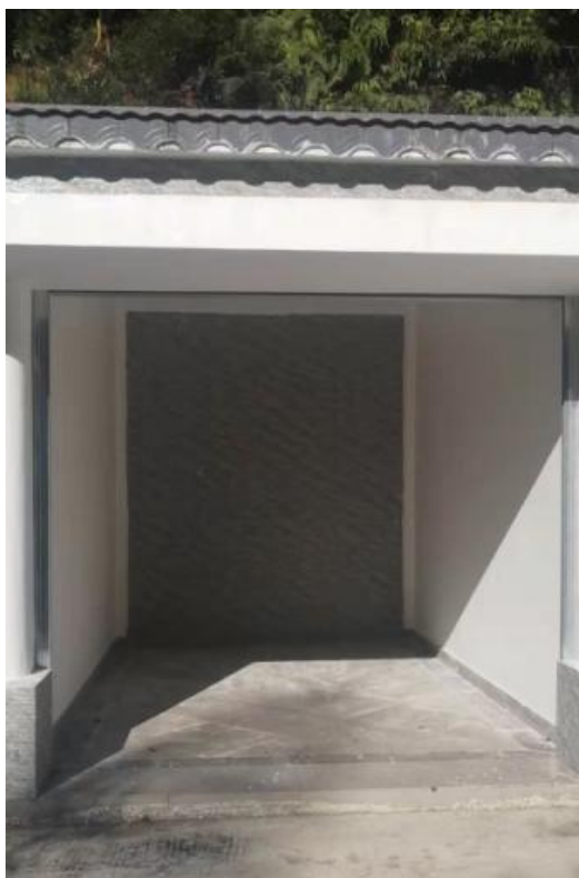
南昆山下坪社区川龙瀑布商铺 7 号
