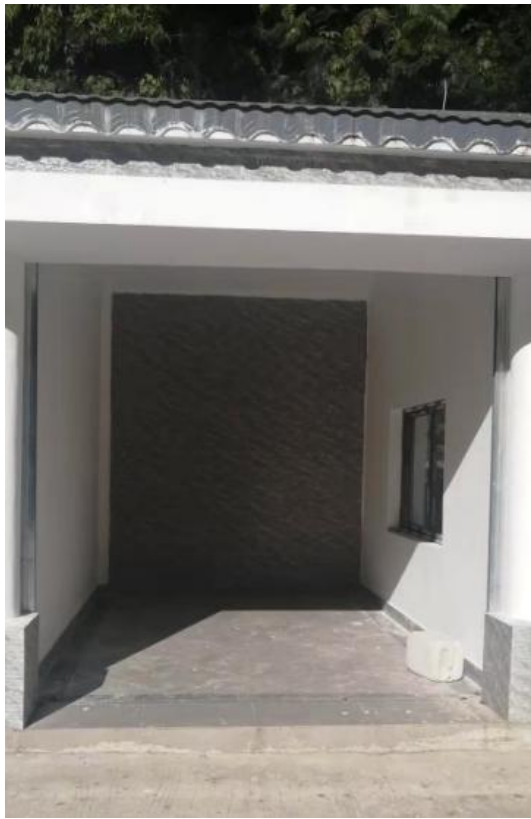
南昆山下坪社区川龙瀑布商铺 5 号
