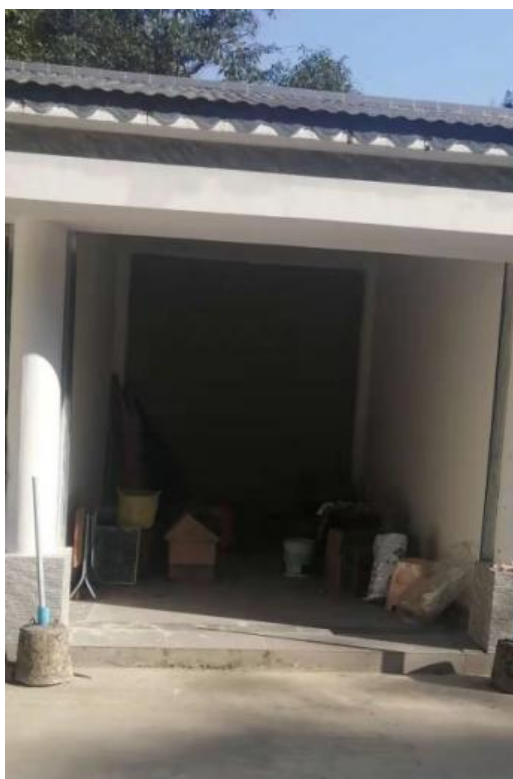
南昆山下坪社区川龙瀑布商铺 2 号
