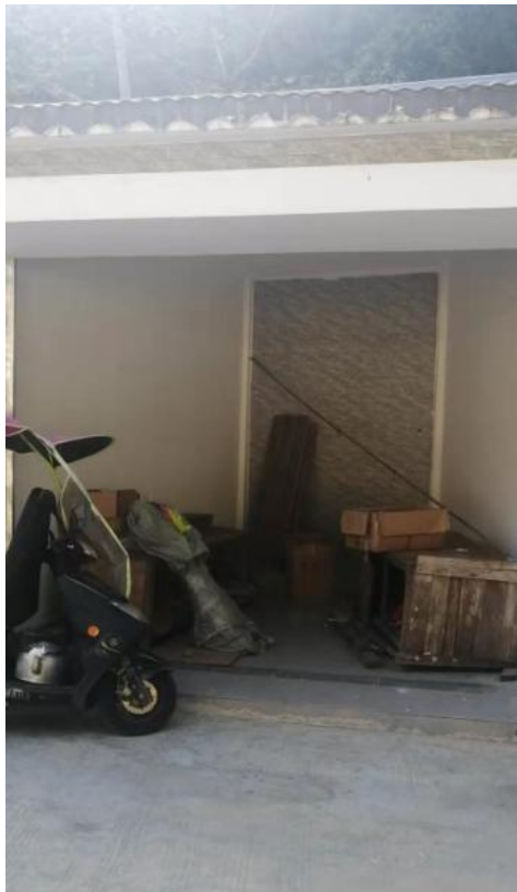
南昆山下坪社区川龙瀑布商铺 13 号
