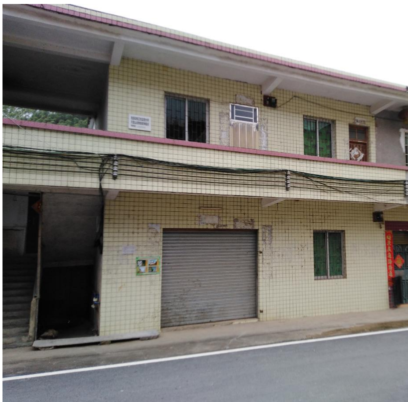
天堂山畜牧站房屋：天堂山天堂东路 10 号
